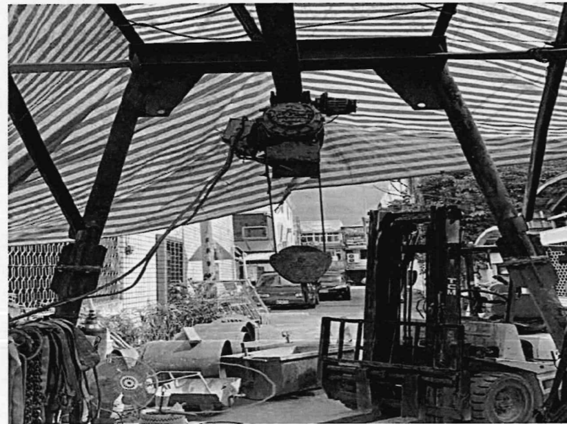
圖 2.2-1 吊掛鐵桶墜落現場照片
